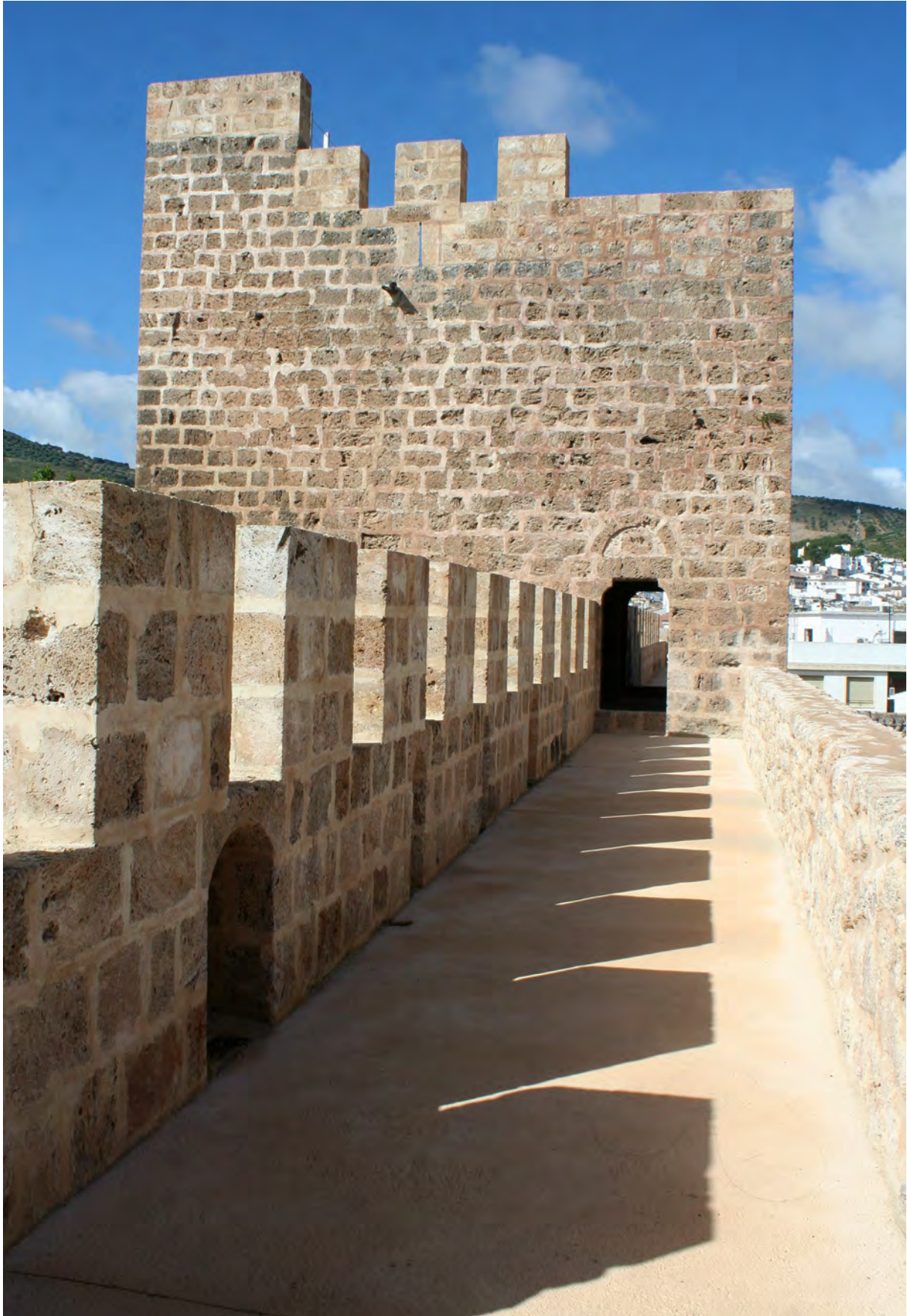
Castillo. Panorámica del adarve del Lienzo 2 tras los trabajos de restauración ejecutados en 2019-2020.
