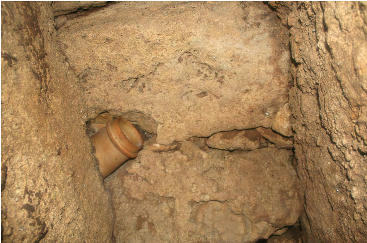
C/ Pasillo de la Zorra, 1. Mina o galería de agua postmedieval. Detalle de la cubierta, con atadores dispuestos en su reutilización como colector de aguas residuales.
