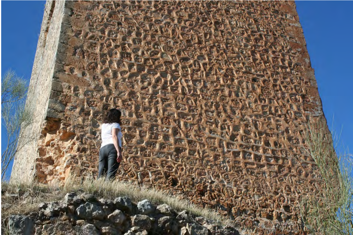
Torre de Barcas. Detalle del rejuntado original medieval, excelentemente conservado, del lado este de la fortificación.
