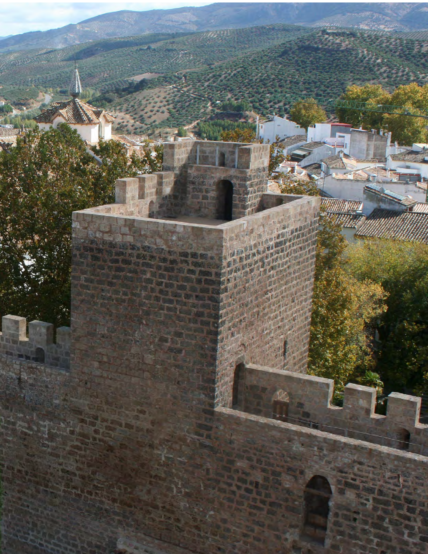
Castillo. Espectacular y renovada imagen tras los trabajos de restauración ejecutados en 2019-2020.
